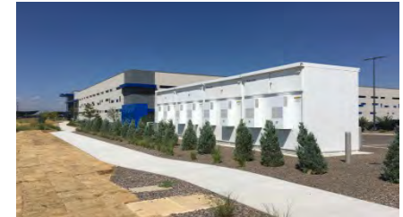
1MW / 2MWh Li-ion
